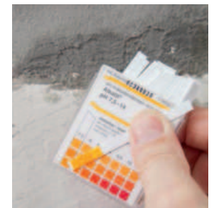
Prüfen des pH-Wertes Hierzu den Untergrund mit destilliertem Wasser benetzen und den pH-Wert mit Indikator- papier bestimmen. Bei ca. 7 liegt ein neutraler Untergrund vor.
