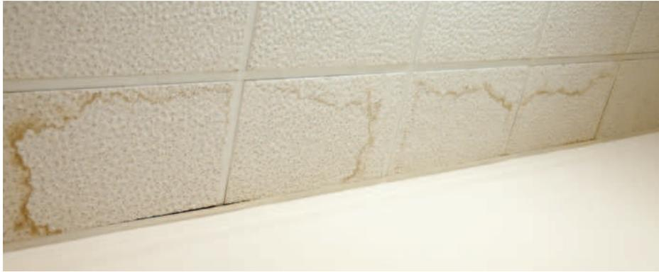
Nikotinablagerungen, Rußflecken, Wasserränder und fettige Verschmutzungen – eine dauerhafte Lösung beim Sanieren von Mineralfaser-Akustikdecken lässt sich nur mit Isolierfarben erreichen. Die richtigen Produkte verhindern das Durchschlagen der wasserlöslichen Verunreinigungen und bilden mit ihrem hohen Deckvermögen eine einheitliche Beschichtung, ohne die Funktionsweise der Akustikdecke zu beeinträchtigen.
